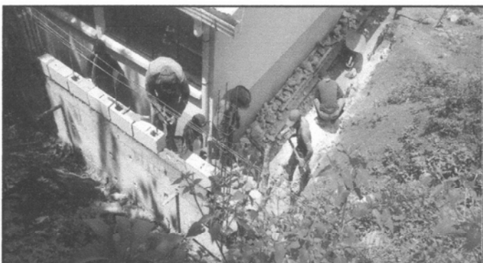
Foto 3: DURANTE EL PROCESO DE CONSTRUCCION DE MURO ATRÁS DEL CENTRO EDUCATIVO
