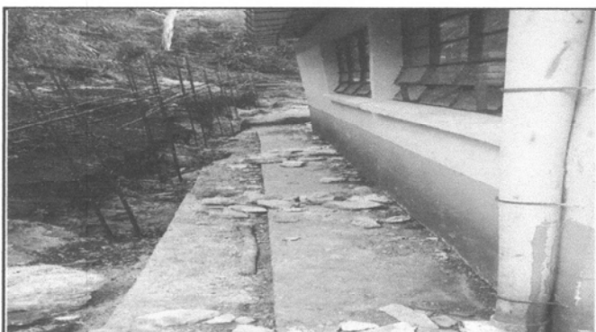
Foto 4: COLOCACION SOLERA DEL MURO PERIMETRAL
