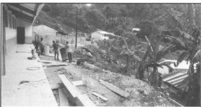
Foto 5: DURANTE EL CAMBIO DE TECHO DE ALJIBE
